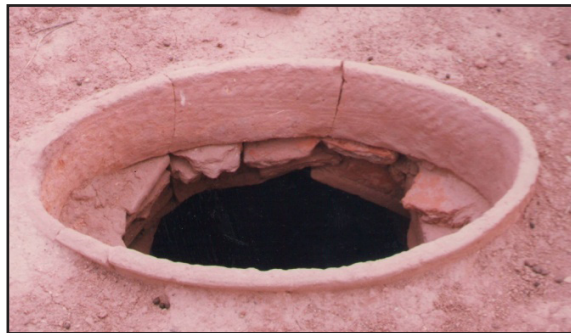
تصویر ۳۳. طوقه‌چینی میله چاه قنات آب نو با قلوه سنگ در قدیم، سال ۱۳۷۶ش (عکس از: نگارنده).
