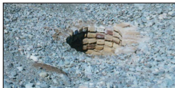
تصویر ۳۵. طوقه‌چینی میله چاه قنات روستای ده نو با آجر در دوره اخیر، سال ۱۳۷۶ش (عکس از: نگارنده).
