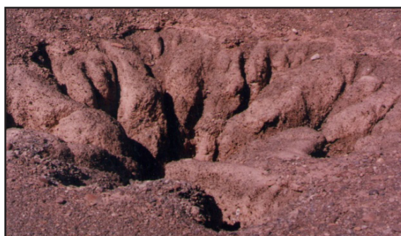
تصویر ۳۸. نمایی از میله چاه تخریب شده توسط آب باران و سیلاب، سال ۱۳۷۶ش (عکس از: نگارنده).
