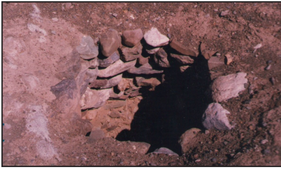
تصویر ۳۳. طوقه‌چینی میله چاه قنات آب نو با قلوه سنگ در قدیم، سال ۱۳۷۶ش (عکس از: نگارنده).
