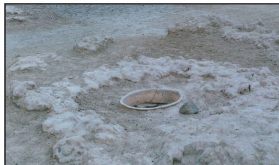
تصویر ۳۴. استفاده از «نا» در میله چاه قنات روستای ده سیف در دوره متاخر، سال ۱۳۷۶ش (عکس از: نگارنده).
